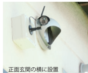
正面玄関の横に設置
