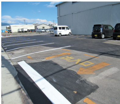
第2駐車場のコンクリート・アスファルト部分をオーバーレイ工事。併せて白線を引き直しました。
