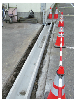
第1駐車場入口の側溝の修繕。既設U字取り壊し、新規U字溝布設。U字溝蓋のグレーチングも交換。
