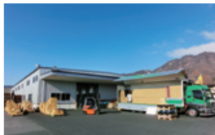
昨年10月に完成した大型倉庫
